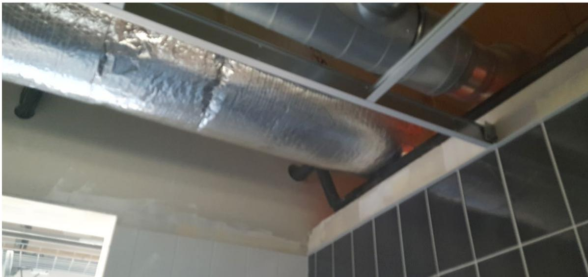
*Les gaines de ventilation entre la centrale et le volume chauffé sont isolées par 100mm d'isolant.*
