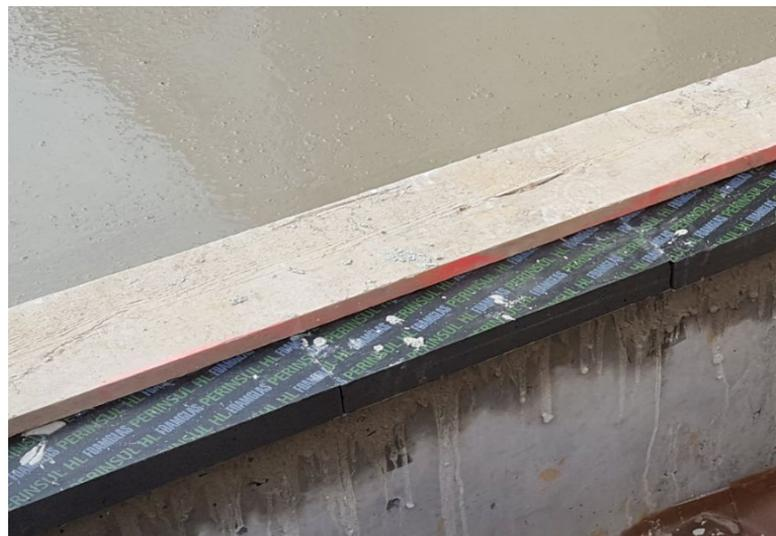
*Bloc isolant résistant à la compression sous le seuil de fenêtre permettant de réduire le pont thermique*
