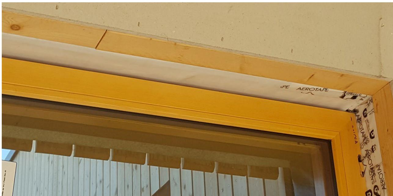
*En plus du joint de mousse pré comprimée de résines sous le châssis de menuiserie, le raccordement et collage soignes du pare vapeur sur la menuiserie à l'aide d'une membrane flexible non tissée munie d'une bande adhésive*
